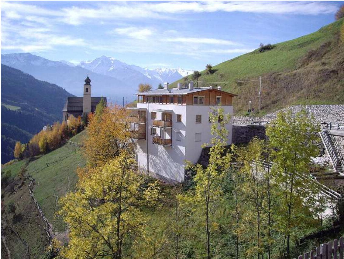
condominio, facciate nord-est
