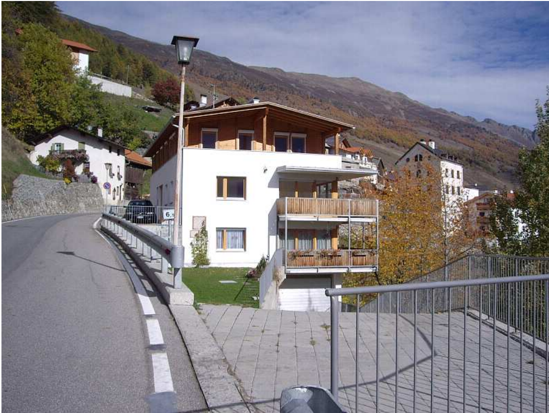
condominio, facciata sud con rampa di accesso
