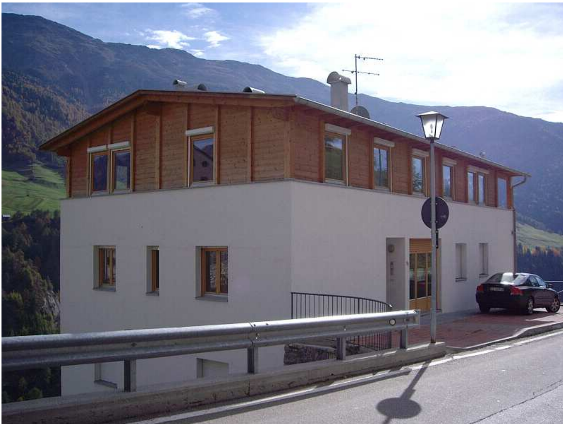
condominio, facciate nord-ovest
